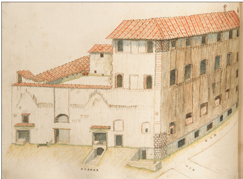
Figure 8: View of the Palazzo del Capitano di Custodia, 1727–1737 (Sapienza 444: 33r). Courtesy of Ministero della cultura, Archivio di Stato di Pistoia, prot. n. 1329–2024.
