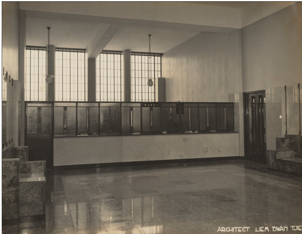
Figure 18: Oei Tiong Ham Concern in Semarang: Interior (1930) (Het Nieuwe Instituut, Rotterdam: Inv. No. LIEM f1-07).
