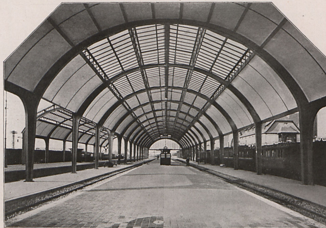
Abb. 3. Bahnsteighalle in Homburg von der Höhe.
